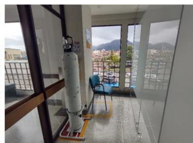
ADECUACION ZONA OXIGENO
