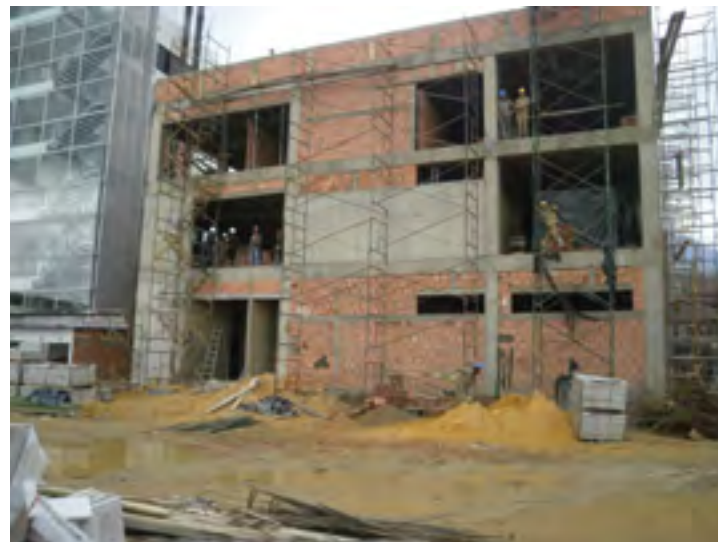
En 2001 se inició la construcción del edificio que albergaría el equipo de aceleración lineal. Fotografías: Archivo INC.
