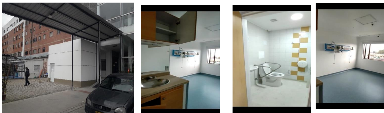
Figura 38. Adecuación y remodelación habitaciones de terapias metabólicas y bunker de decaimiento de desechos radioactivos.
