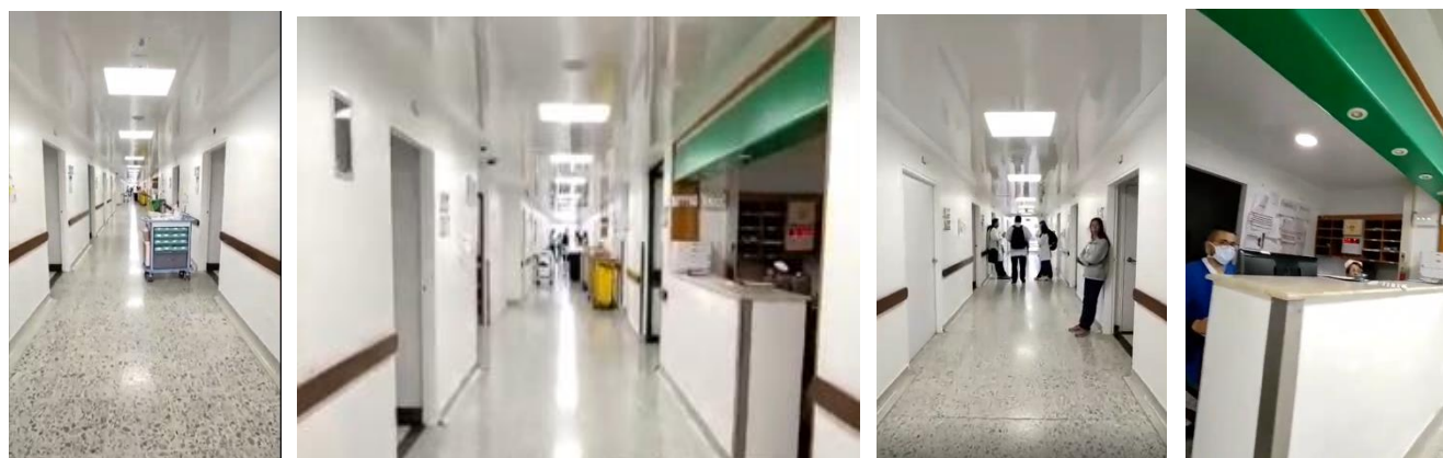
Figura 39. Adecuación pasillo piso 4to Hospitalización
