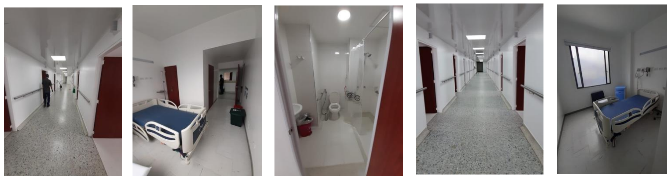
Figura 37. Construcción y adecuación de 30 habitaciones de hospitalización.
