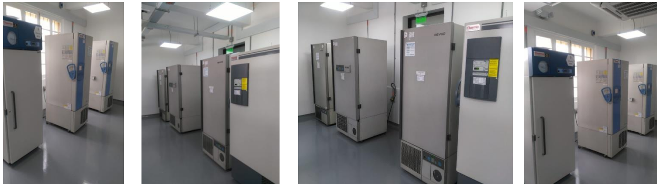
Figura 34. Adecuación área de ultra congeladores biología del cáncer.
