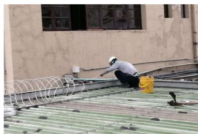
Mantenimiento preventivo y correctivo del apantallamiento y sistema de pararrayos
