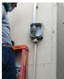
Mantenimiento preventivo y correctivo del apantallamiento y sistema de pararrayos
