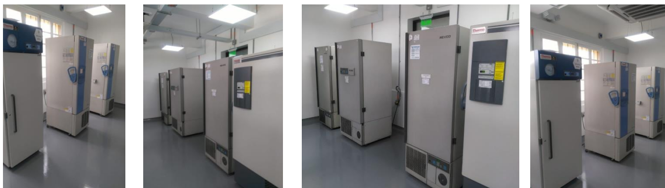
Figura 31. Adecuación área de ultra congeladores biología del cáncer.
