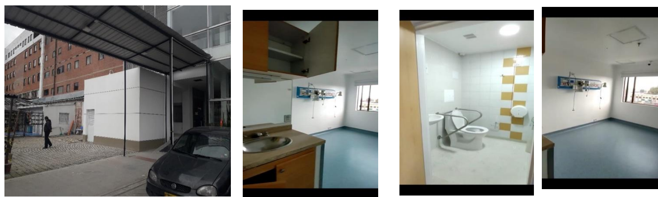
Figura 35. Adecuación y remodelación habitaciones de terapias metabólicas y bunker de decaimiento de desechos radioactivos.
