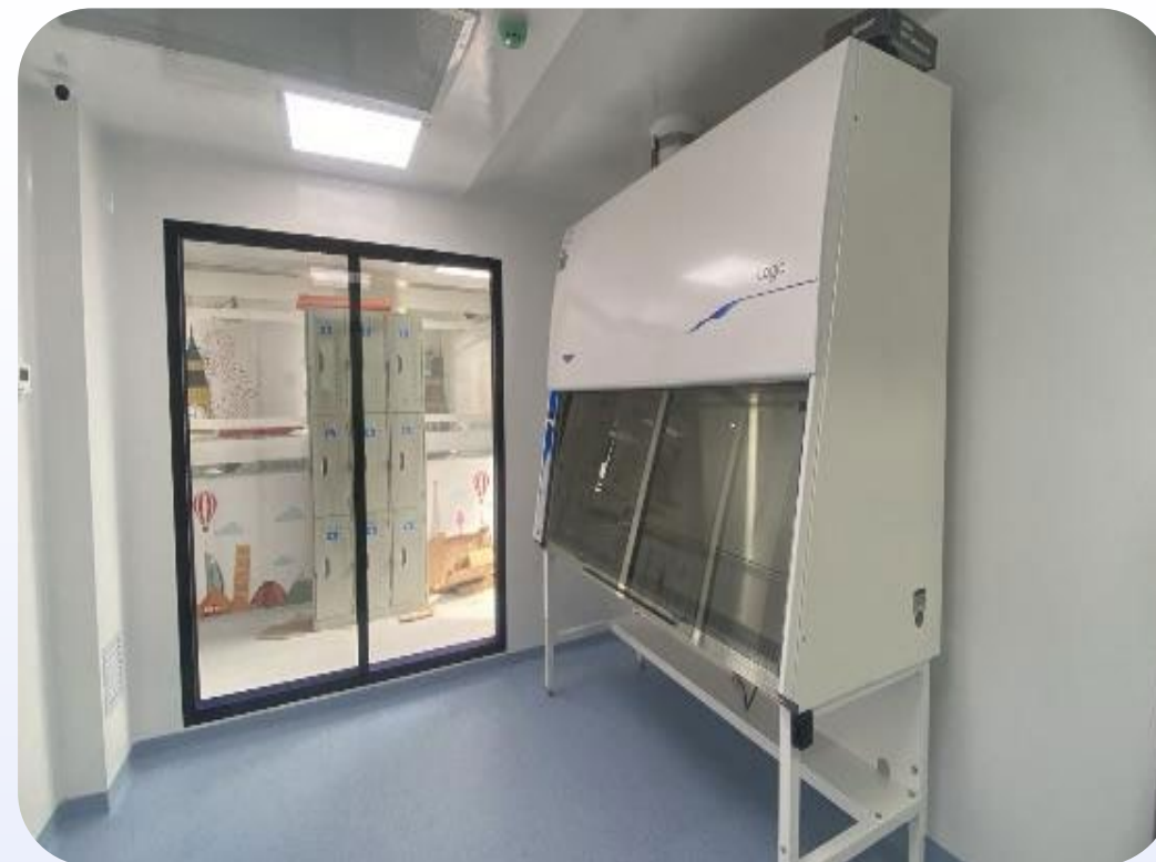
Construcción y adecuación Central de Mezclas Piso 7 (octubre)
