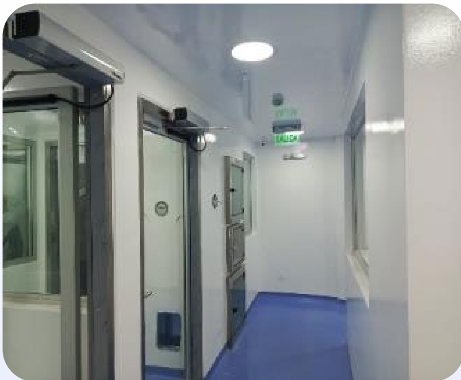
Adecuación y reordenamiento arquitectónico Central de Mezclas piso 2 edificio de Patología para el servicio Farmacéutico (agosto)
