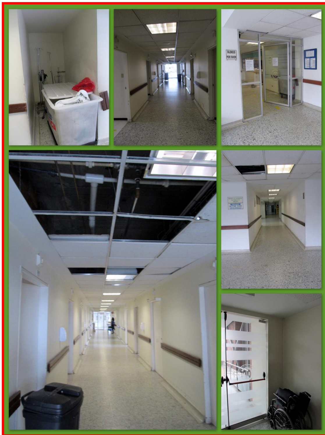
ZONA HALL DE CIRCULACION HOSPITALIZACION SERVICIOS 3 PISO.
