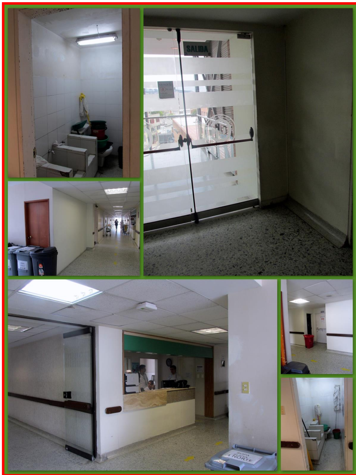
ZONA HALL DE CIRCULACION HOSPITALIZACION SERVICIOS 4 PISO.
