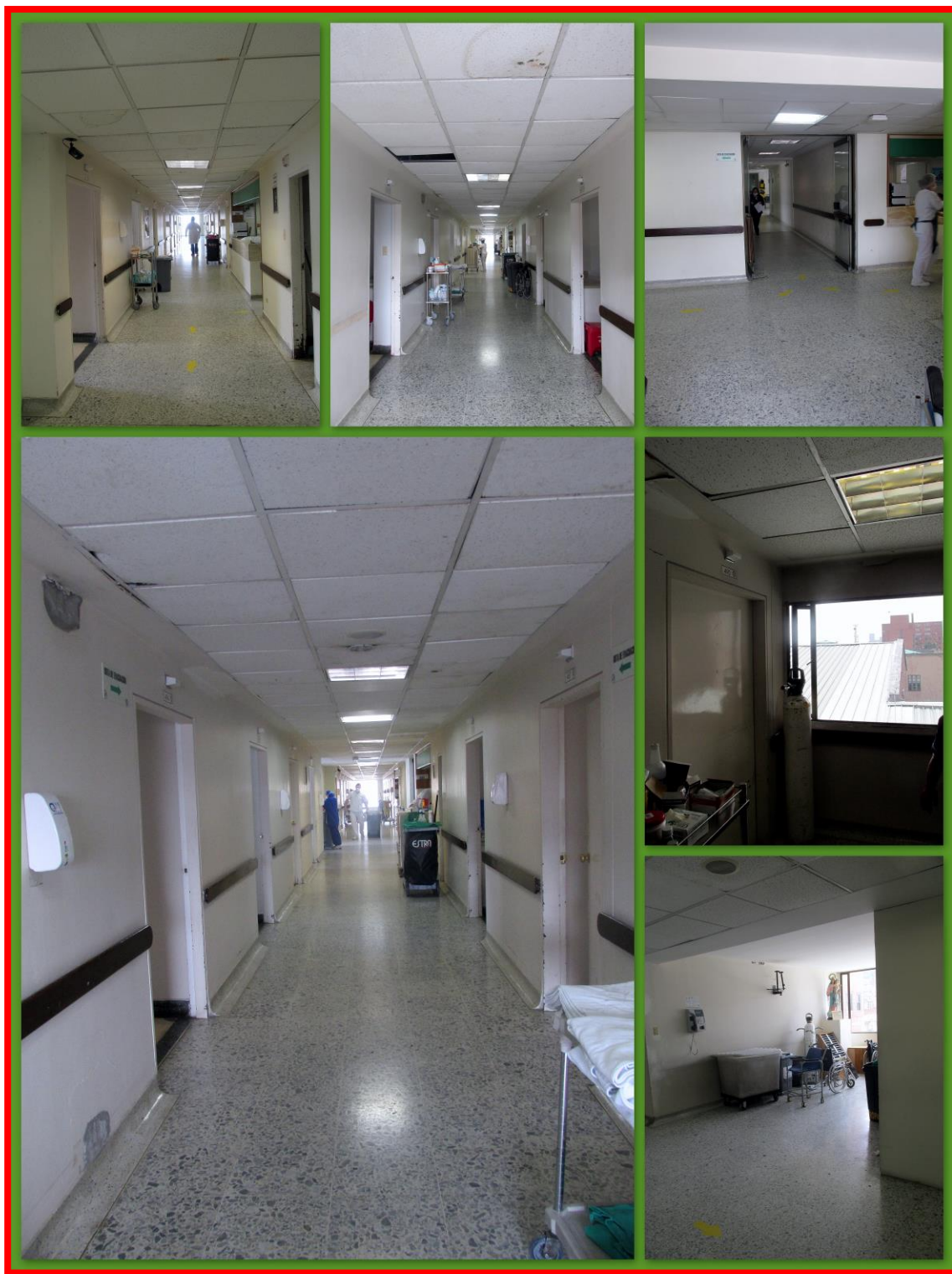
ZONA HALL DE CIRCULACION HOSPITALIZACION SERVICIOS 4 PISO.
